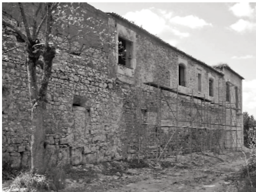
Figura 6 – Perspectiva fachada nascente durante os trabalhos de picagem dos paramentos.
