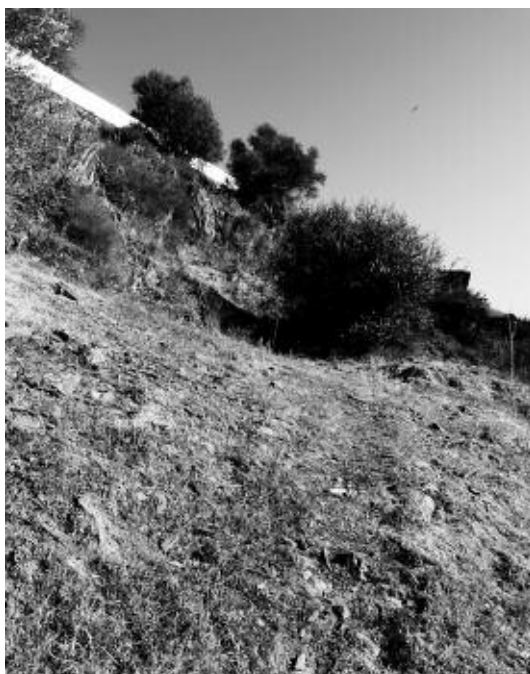
Figura 8 – Vía de la Porta do Buraco , séptimo tramo, es una área semicompactada, cuya matriz está conformada por guijarros angulosos y tierra.
