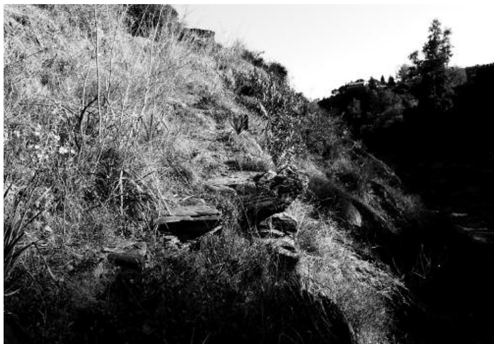
Figura 10 – Vía de la Porta do Buraco , séptimo tramo, la parte inferior que enlaza con el octavo tramo está derruyendo ante los efectos erosivos de las riadas ( cheías ).
