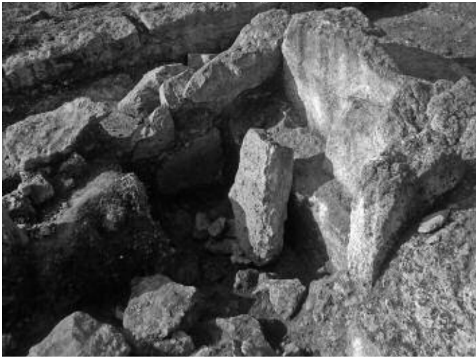
Figura 6 – Muro 17, derrube da estrutura.
