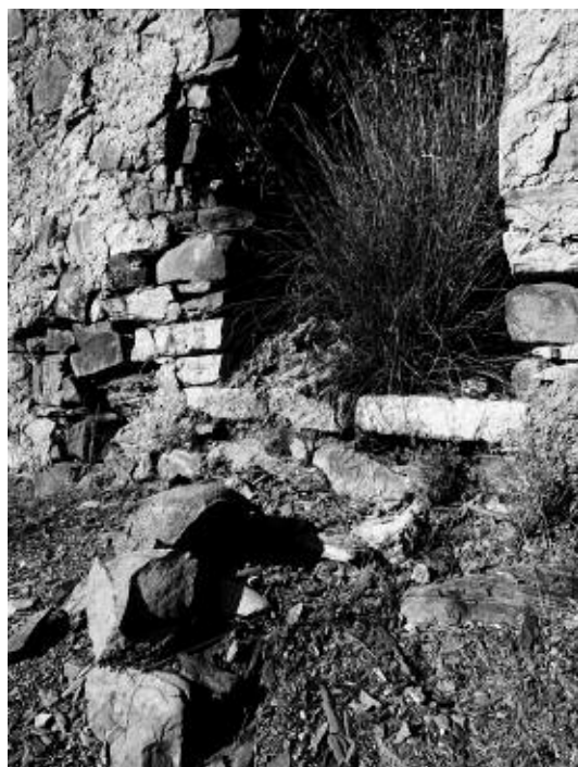
Figura 34 – Otra vista de la puerta de la casa de apoyo ( casa de apoio ), del Moinho das Bruxas , donde se distinguen las piedras que han colapsado de la jamba izquierda.
