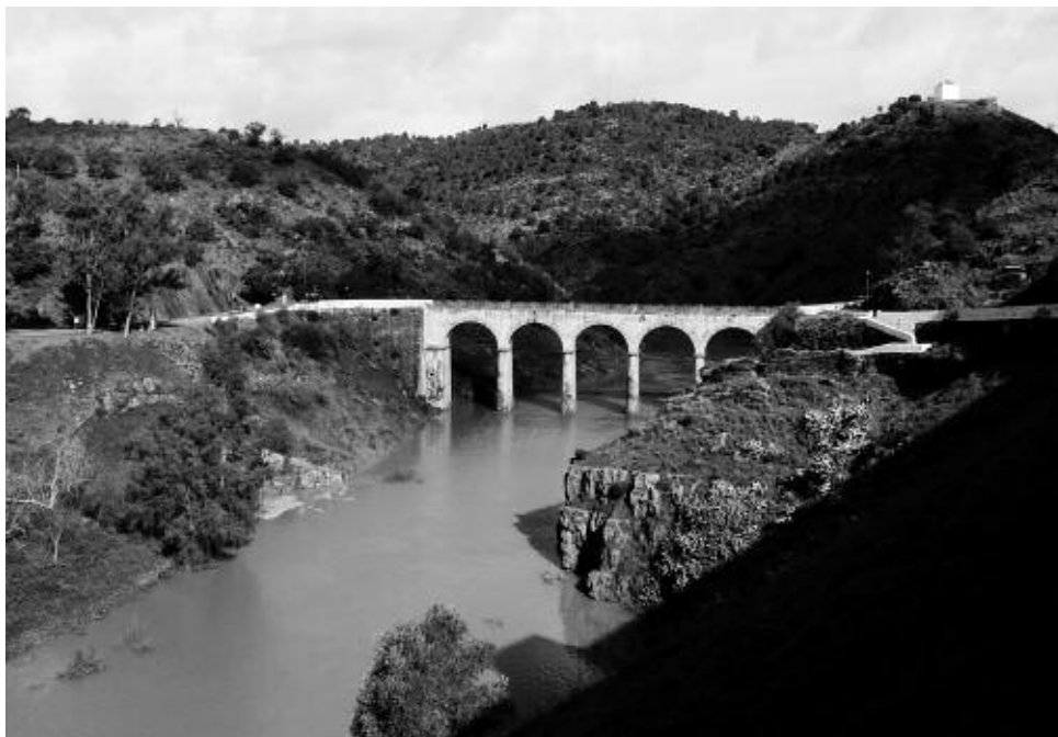
Figura 12 – Las persistentes e intensas lluvias del invierno 2009-2010 provocaron riadas frecuentes en la Ribeira de Oeiras . Compárese la altura del aluvión respecto de la fotografía previa (fotografía tomada el 22 de febrero de 2010).
