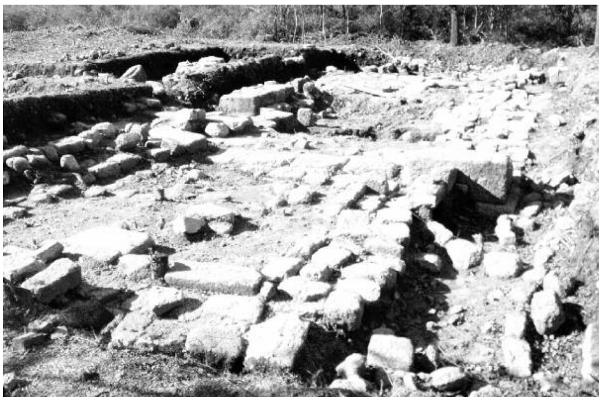
Igreja de S. João após desmontagem das banquetas e intervenção.
