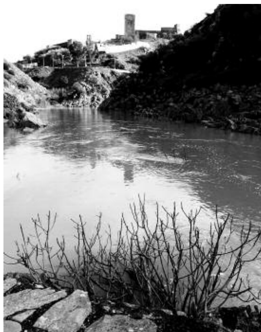
Figura 45 – Moinho das Bruxas con la higuera ( Ficus carica ) que crece sobre la estructura, en una riada (fotografía tomada el 14 de enero de 2010).
