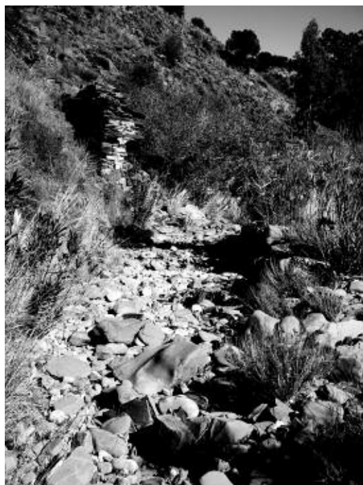
Figura 73 – Lecho del canal de alimentación ( levada ), río arriba ( a montante ) de la Azenha da Martulheira . Al fondo, se observa la pared Oeste de ésta (original en color).
