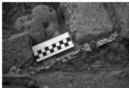
Figura 8 – Reboco exterior da casa I.
