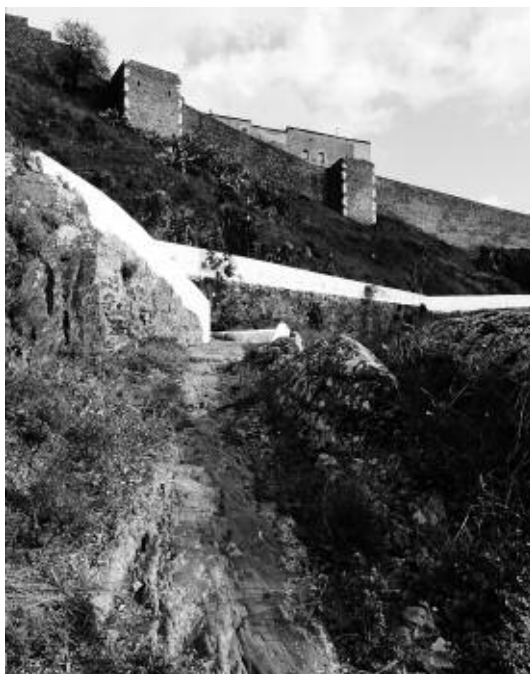
Figura 5 – Vía de la Porta do Buraco , cuarto trecho, sendero recortado en la roca.
