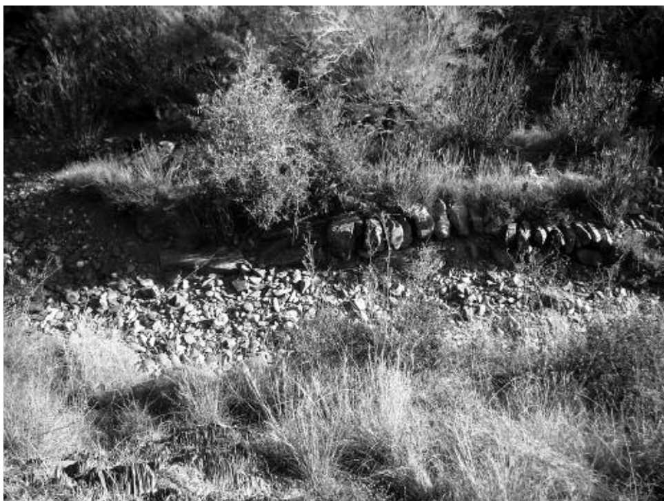
Figura 74 – Canal de alimentación ( levada ) de la Azenha da Martulheira . Vista vertical de la sección situada río arriba ( a montante ), respecto del edificio laboral. Fotografía tomada el 19 de noviembre de 2008 (original en color).
