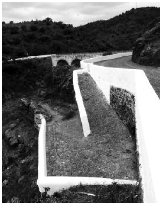
Figura 4 – Vía de la Porta do Buraco , segundo y tercer tramos, correspondientes a dos rampas empedradas ( calçada ) (fotografía original en color).
