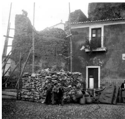
Figura 3 – Desmantelamento da torre circular nos anos 50 do século XX.
