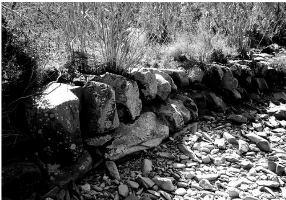
Figura 77 – Vista del mismo tramo, de la pared sur del canal de alimentación ( levada ) de la Azenha da Martulheira (original en color).
