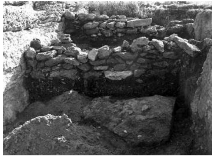
Figura 7 – Muro 18, derrube da laje.
