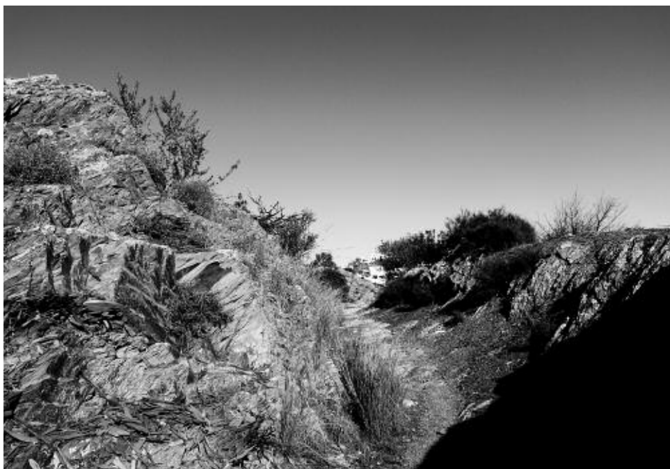
Figura 15 – Vía de la Porta de Beja , ramal al complejo molinero de la Ribeira de Oeiras y a la Horta da Martulheira . Tramo recortado en la roca de la ladera.
