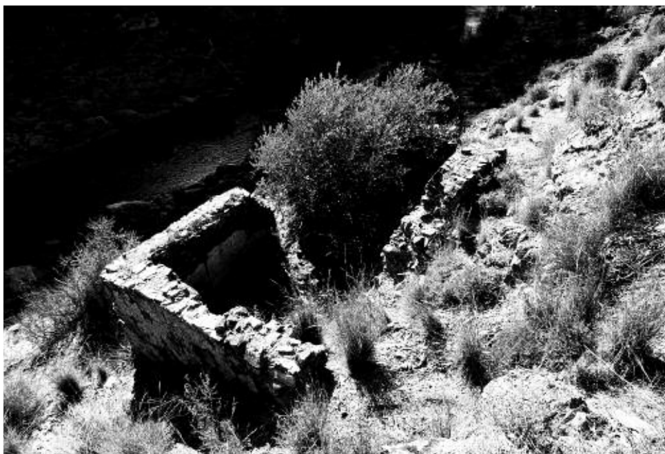
Figura 31 – La casa de apoio ( casa de apoio ) del Moinho das Bruxas presenta una problemática de deterioro compleja. En la toma se observan dos problemas críticos: el olivo silvestre ( Olea europaea var. sylvestris ; cfr. nota 7) que crece en su interior y el colapso de parte de la pared Norte, que da a la ladera; así mismo, en el muro Este se observa el hueco de las piedras que empezaron a caer.
