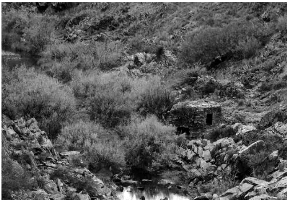
Figura 50 – El entorno del Moinho das Bruxas está dominado por el arbusto tamariz ( Tamarix sp. ) una especie ripícola de la flora autóctona mediterránea que, en principio, no parece afectar a esta estructura hidráulica (detalle de la fotografía).
