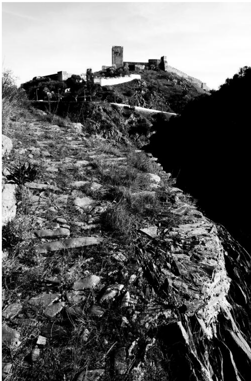
Figura 17 – Vía de la Porta de Beja , ramal al Moinho das Bruxas . Tramo con obra a manera de muro de contención, para salvar las diferencias topográficas de la gradiente del terreno, así como de empedrado ( calçada ). Al fondo, una vista del castillo de Mértola avala la riqueza paisajística, cultural e histórica de este legado arquitectónico-laboral.
