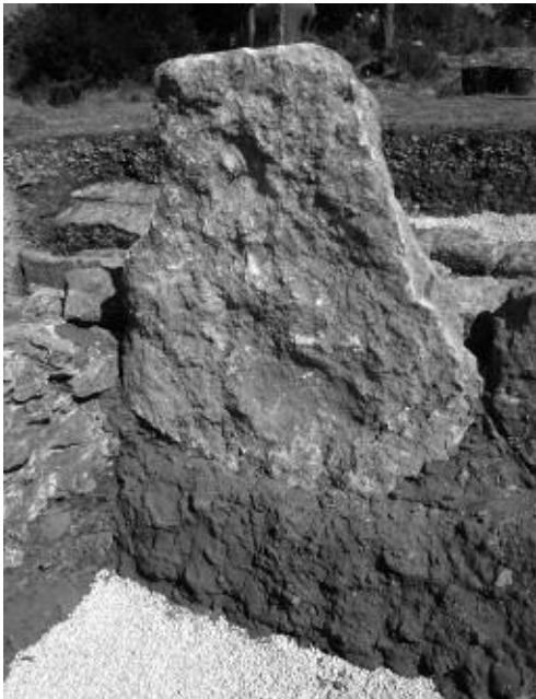
Figura 8 – Muro 18, aspecto final da intervenção.
