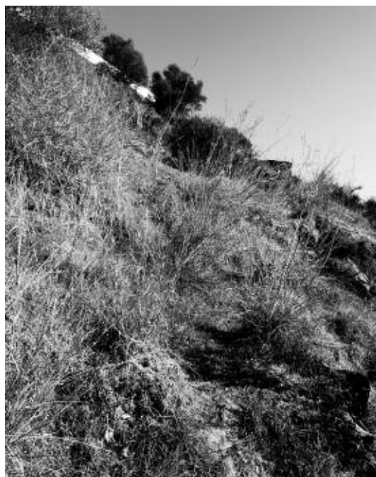
Figura 9 – Vía de la Porta do Buraco , séptimo tramo, la parte situada en cotas inferiores presenta hierba crecida.
