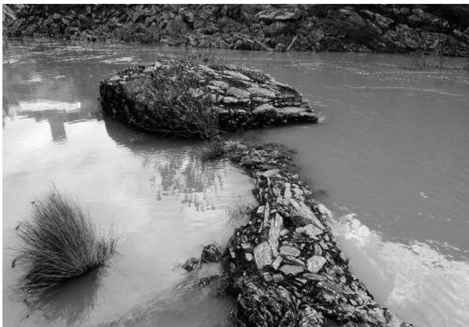
Figura 49 – La pared izquierda del canal ( levada ) del Moinho das Bruxas es un elemento estructural que soporta la fuerza de las avenidas invernales, de allí la necesidad tanto de restaurar las piedras caídas como de proporcionarle cualquier medida de restauración preventiva que requiera a futuro.
