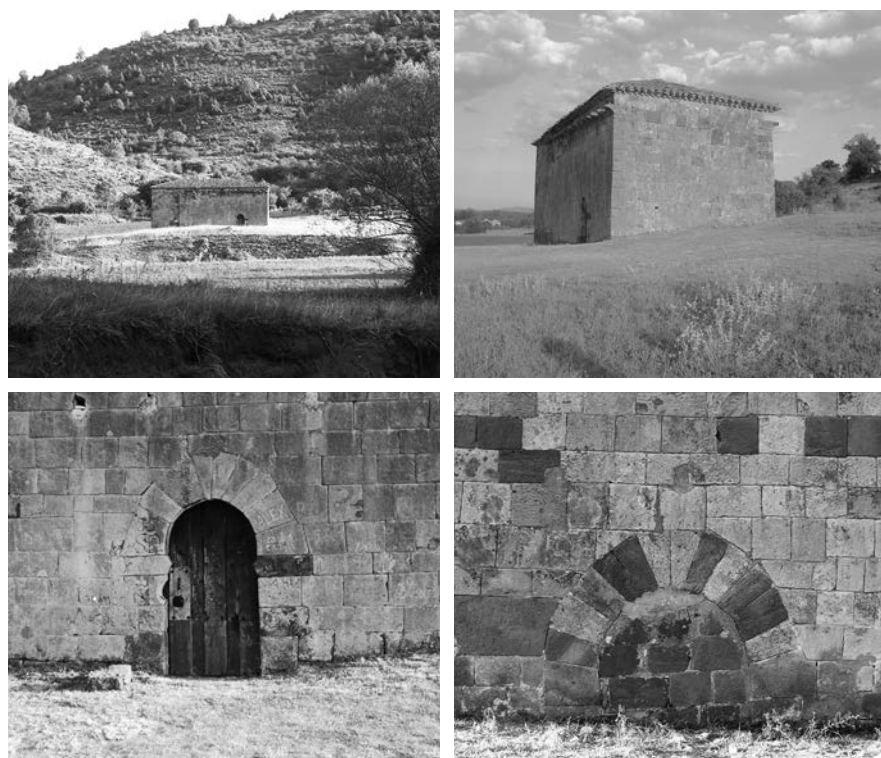
Figura 2 – a) La ermita de S. Juan, en el campo, fuera de Barbadillo del Mercado (Burgos); b) Fachada W.; c) Arco de la puerta del lado N; d) Arco enterrado hasta la línea de impostas. Obsérvense las dovelas.
