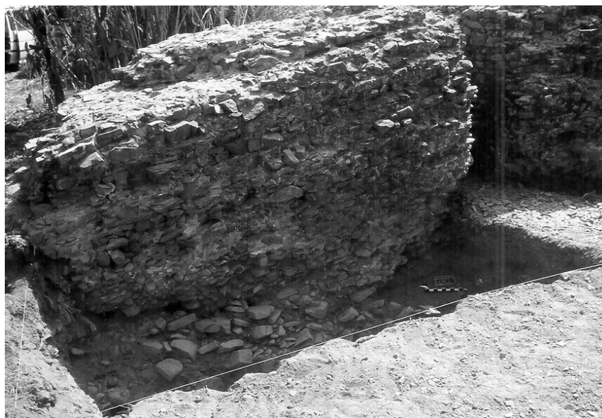
Figura 11 – Barragem do Álamo. Vista do troço do paredão da barragem que basculou, provavelmente por sobre-excavação da fundação. Foto J. L. C.
