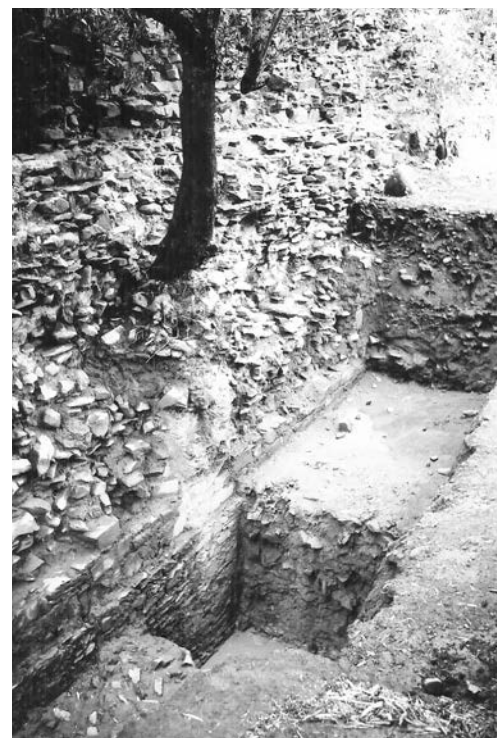
Figura 6 – Barragem do Álamo. Vista parcial do paramento de montante, fortemente erodido até uma determinada profundidade, abaixo da qual se apresenta intacto, conservando na íntegra o revestimento de blocos de grauvaque arrumados. Foto J. L. C.
