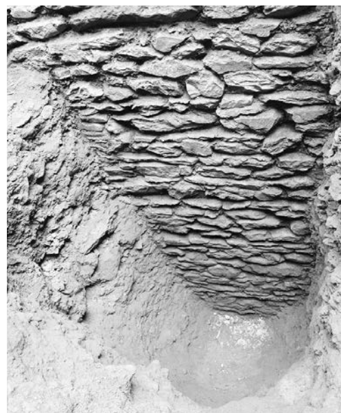
Figura 17 – Barragem do Álamo. Corte estratigráfico efectuado nos depósitos acumulados na parte mais profunda do vale, correspondente ao Corte GH (ver Fig. 16), evidenciando a notável qualidade do paramento de montante da barragem. Observe-se no fundo, lascas de xisto/grauvaques correspondentes ao substrato geológico, sobre os quais assentou depósito argiloso muito fino. Foto A. G.
