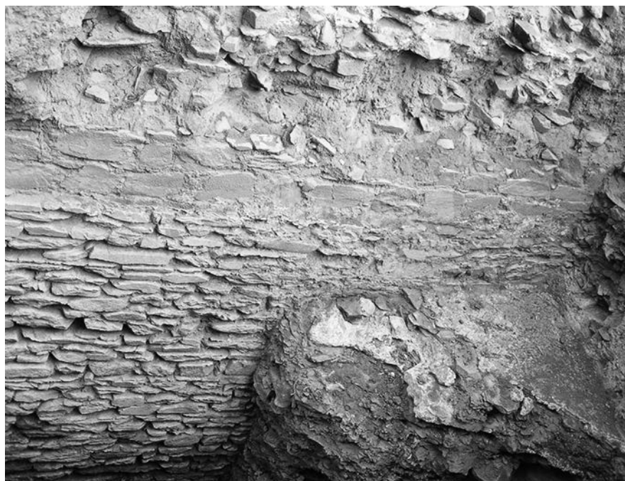
Figura 20 – Barragem do Álamo. Fino leito de argamassa amarelada, encostada ao paramento de montante da barragem, sobreposto por outro leito de argamassa mais esbranquiçada, embalando pequenos elementos de grauaque, observado no limite meridional da sondagem 4 (corte 3, ver Fig. 15). Foto J. L. C.
