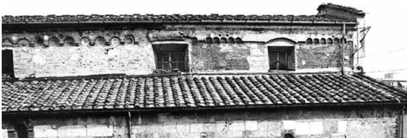
Figura 34 – S. Stefano extra moenia. Fianco sud della navata centrale: a sinistra della freccia strutture in pietra (metà XI s.), a destra in laterizi (fine XII s.).
