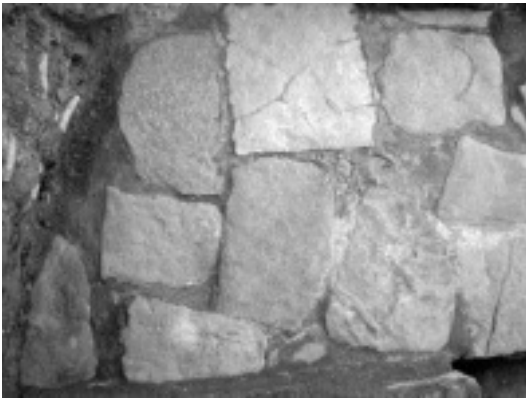
Foto 5 – Pormenor do Pavimento do Pátio da Casa III
