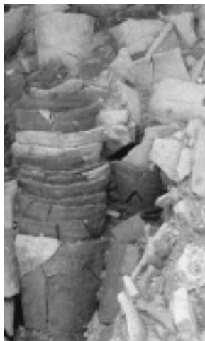
Foto 3 – Pormenor do Depósito de Telhas
