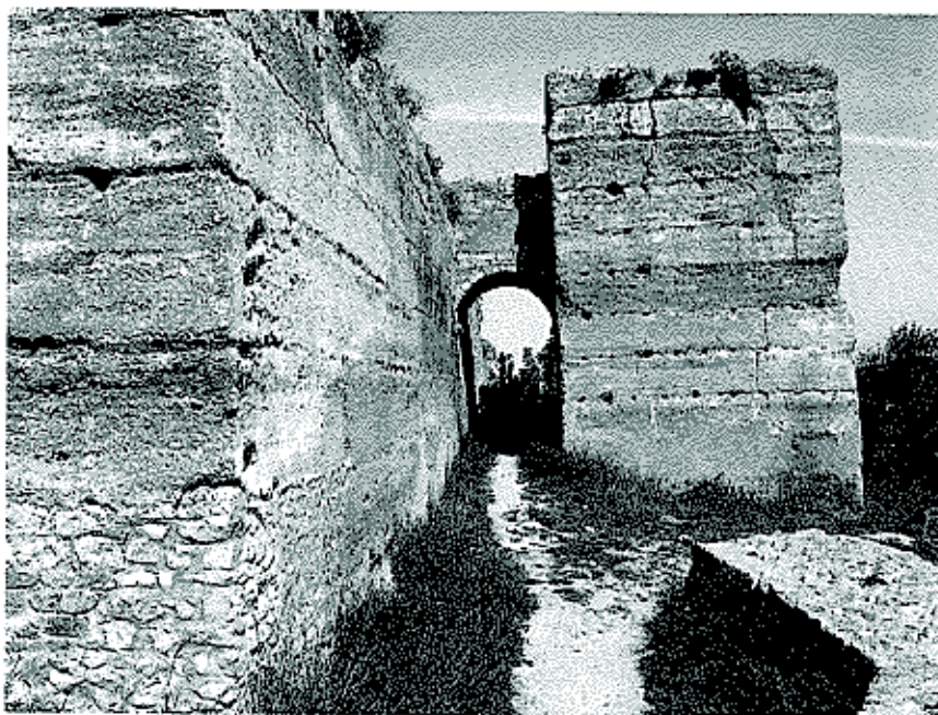
Fig. 11 – 1. Castelo de Paderne visto de Noroeste. 2. Torre albarrã e passagem para a muralha, visto da barbaca.
