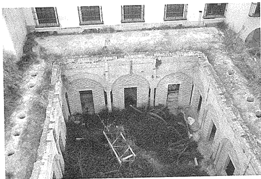
Lám. I - Baños de la Reina Mora. Al-bayt al-wastani. Foto M. Valor.
