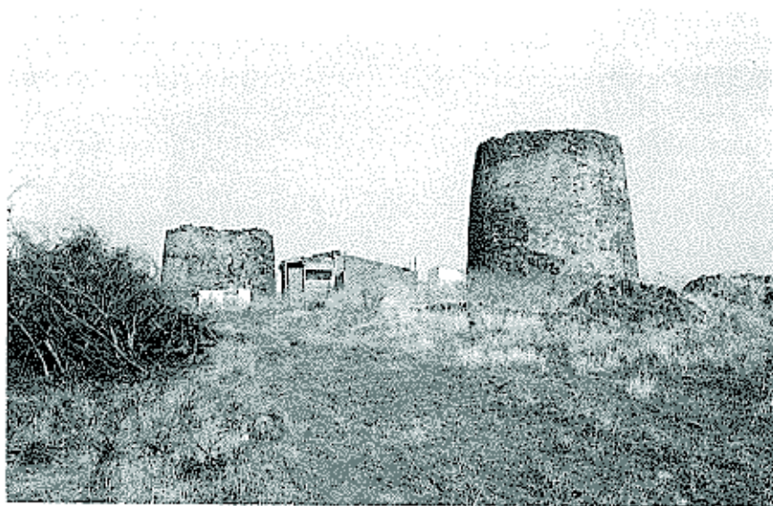
Fig. 5: Restes de dos molins de vent a l'Alcària Ruiva.
