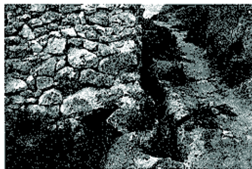
Foto 4 - Acequia excavada en la roca. Detalle del triple partidor hacia las terrazas.
