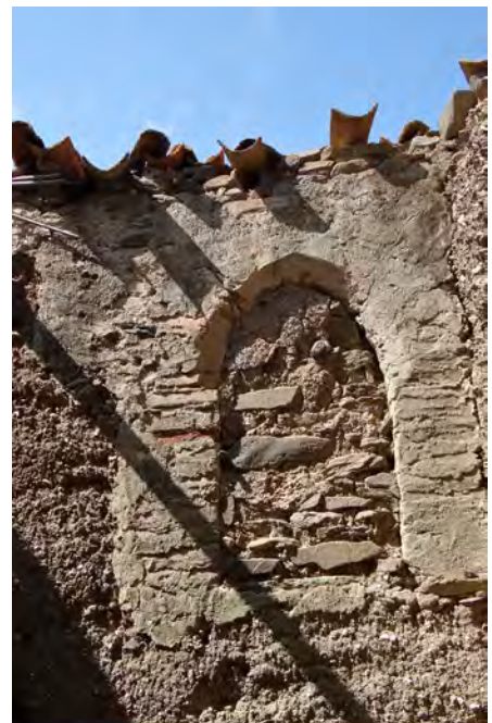
Fig. 45 · Vão com arestas chanfradas
