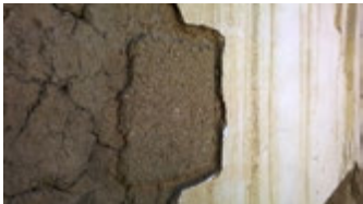
Sondagem (A), solução de revestimento interior constituída por duas camadas de rebocos
