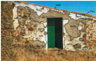
Unidades estratégicas da fachada noroeste do edifício principal (registro de campo)
