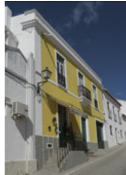
Casas de escada central na rua da República e na rua Serrão Martins
